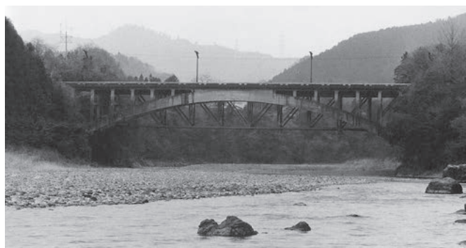
コンクリート・アーチ橋の万年橋 『鉄の橋百選』(H6)より
