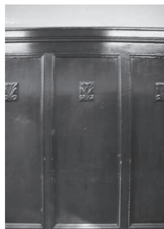
木製の壁面パネル
