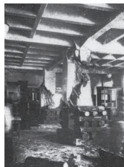
震災直後の陳列室の破壊した柱
