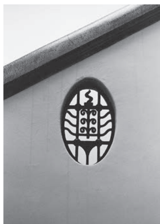
階段手すりの鑄鉄飾り
