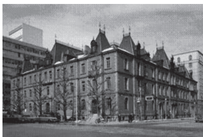
旧三菱一号館外観
