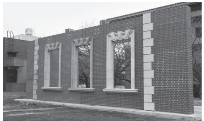
図書館前に保存された煉瓦壁試験体
