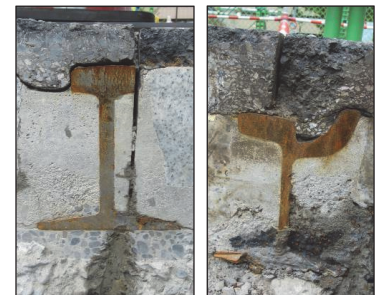
標準レールと溝付きレールの断面
